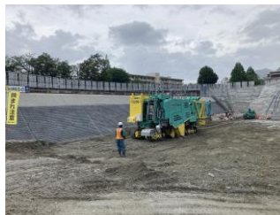
調整池岩盤掘削(教育施設近接)
