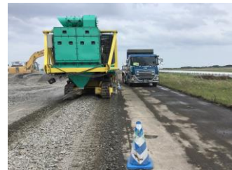
コンクリート舗装版撤去(飛行場内)
