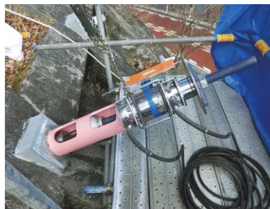
グラウンドアンカー引張試験
