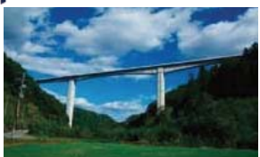
山間部における片持架設工法によるPC橋
