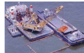
END工法を用いた浚渫工事
