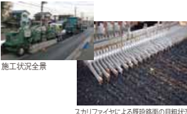
スクリファイヤによる既設路面の目録状況
