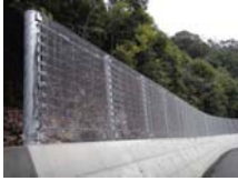
施工場所:愛媛県南宇和郡愛南町
