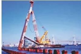
鋼管杭打設(杭打船)
