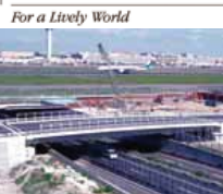
世界最大のダクトル橋:羽田空港GSE橋梁
