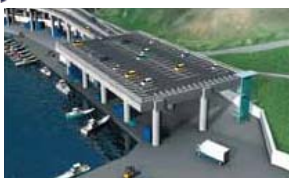
避難所として活用可能な荷捌き場の人工地盤
