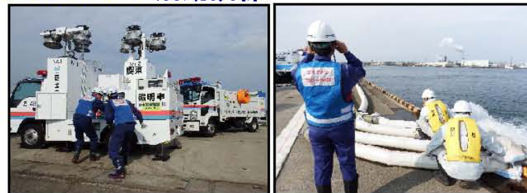
関東・北陸地整による緊急排水作業
