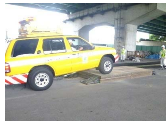
防災訓練の実施状況（土嚢による段差修正）
