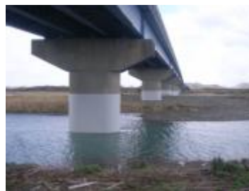
緊急輸送道路の橋梁耐震補強
