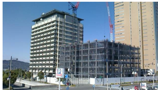
地上部鉄骨建て方工事中 （平成28年3月現在）
