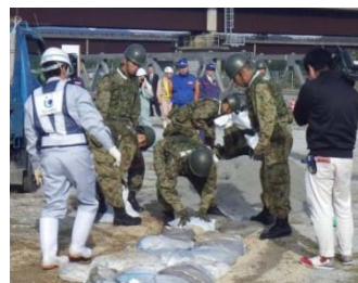
土嚢による亀裂・段差解消
