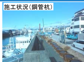
高知港海岸 既設海岸堤防の耐震補強 H27年度実施箇所
