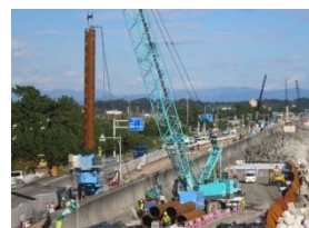
高知海岸／長浜工区 液状化対策施工状況(高知市)
