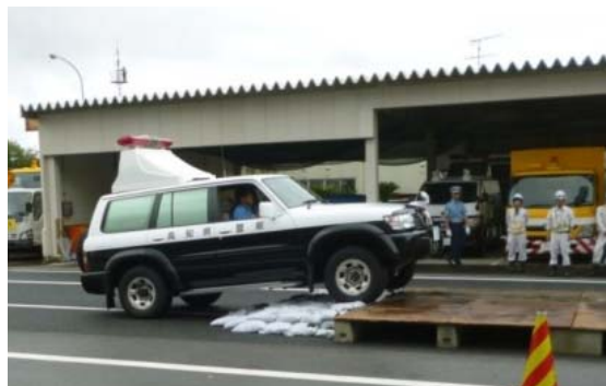
防災訓練の実施状況（土嚢による段差修正）
