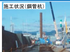
高知港海岸 既設海岸堤防の耐震補強 H27年度実施箇所
