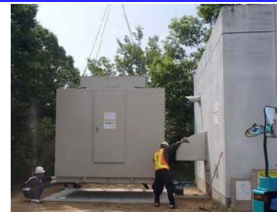
非常用発電機燃料タンク増設の実施状況 (瀬戸中央自動車道 坂出IC)
