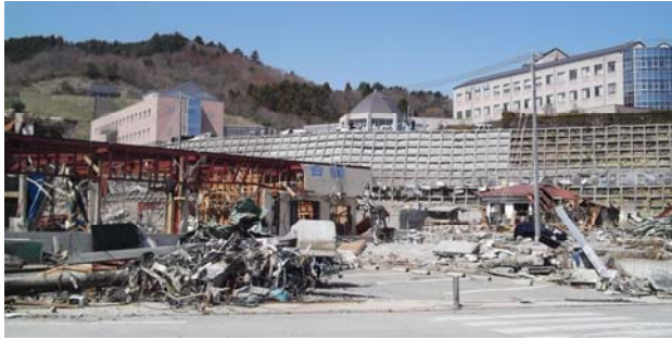
◇高台に配置された宮城県女川町立病院等
