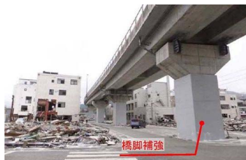
【耐震補強済み(鋼板巻立補強)】
