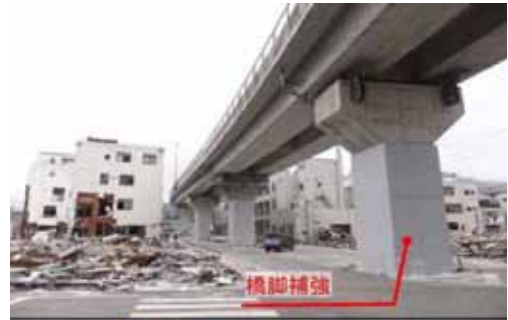
◇橋脚耐震補強(国道45号)
