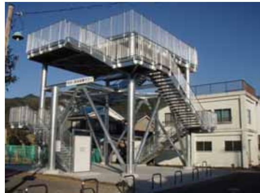
◇津波避難タワー（徳島県海陽町）
