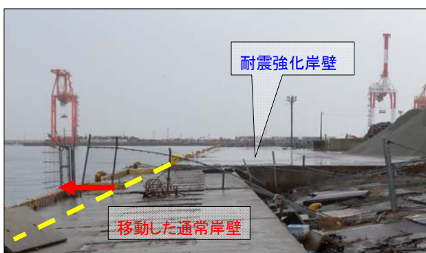
■耐震強化岸壁(仙台塩釜港 仙台港区)
