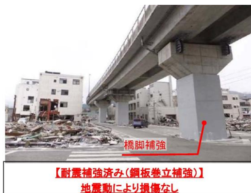
■橋脚耐震補強(国道45号)
