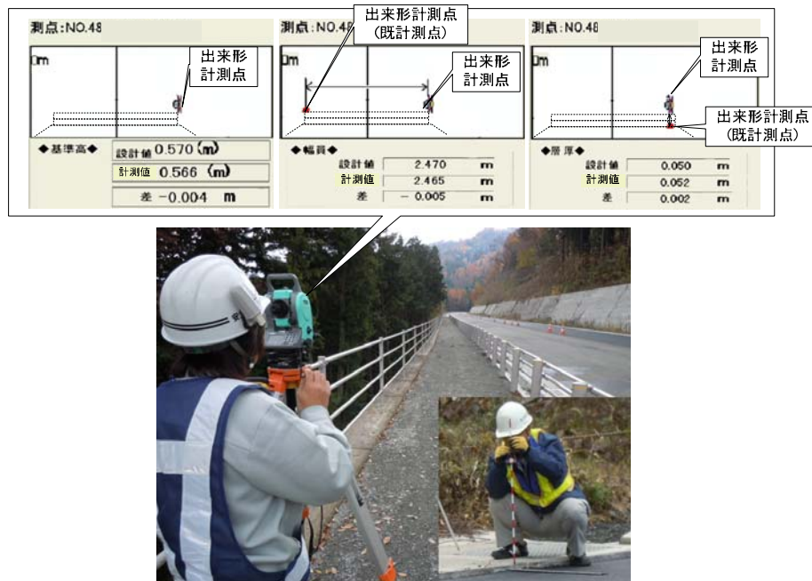
図-3 出来形計測状況
