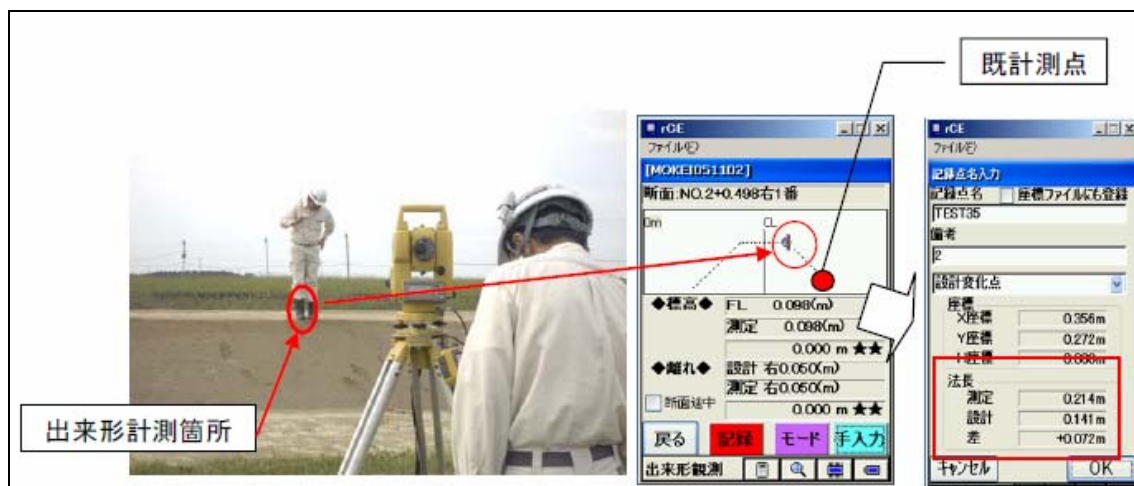
図－3 出来形計測状況及び現場確認画面例
