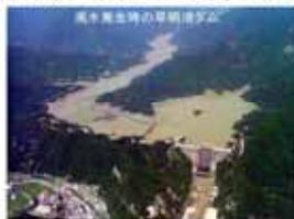
濁水の発生原因は上流域から流出する微細土砂であり、濁水現象の軽減のためには、土砂の生産源対策が必要。
