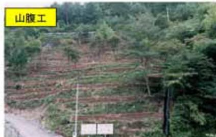
砂防堰堤の設置による土砂流出の抑制及び崩壊地への山腹工により林相転換等、森林の多面的機能を向上し、崩壊や表面侵食を少なくし、微細土砂の流出を抑え、濁水現象の軽減を図る。
