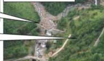
砂防えん堤により土砂を捕捉
