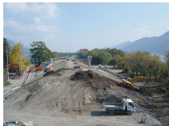
■堤防工事の様子(芝生箇所)
