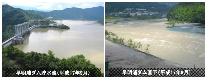
■早明浦ダムの濁水発生状況
