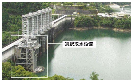
■早明浦ダムの選択取水設備
