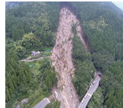
▲平成30年7月豪雨の被災状況
