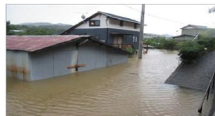
▲平成26年8月台風の様子（高知県いの町加田地区）
