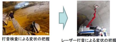
▲トンネル点検での活用例
