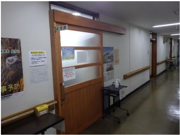
写真 バリアフリー化を目的として変更したスライドドア
