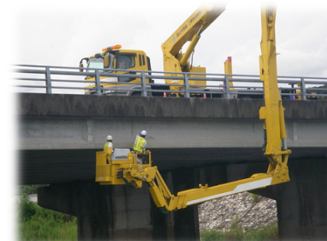
▲高所作業車による定期点検
