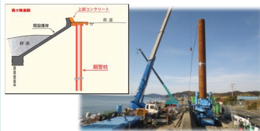
▲海岸堤防の補強（事例）
