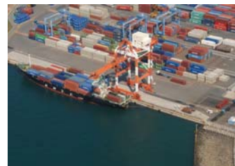
▲国際物流ターミナルの整備（事例）
