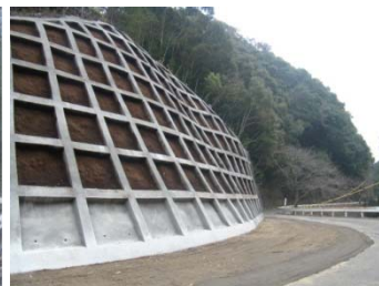
▼道路法面の防災対策
