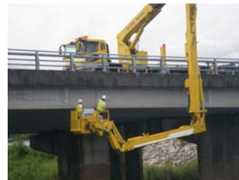
▼高所作業車による定期点検
