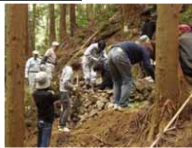
遍路道修復のボランティア作業
