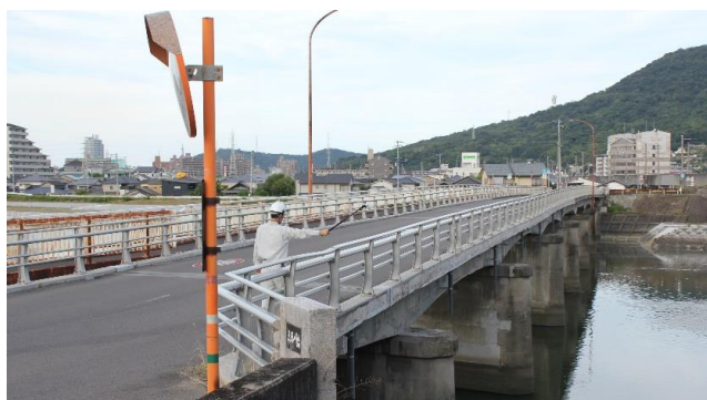
図-2 桁側面部での近接撮影状況
