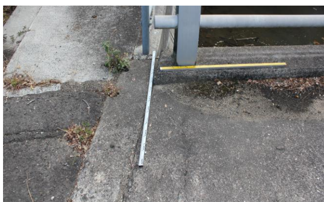
図-3 寸法情報を取得するための基準尺
