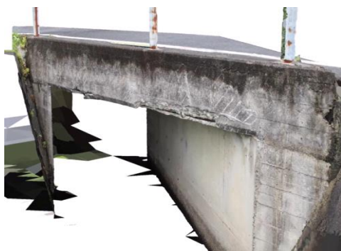
図-4 A 橋梁の3次元モデル化の状況
