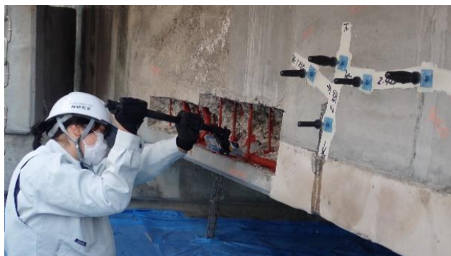
図-1 桁側面部での近接撮影状況
