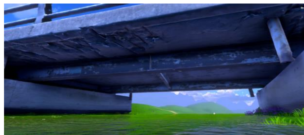
図-8 C橋梁の桁下面の状況
