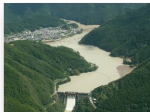
図5 永瀬ダムの濁水状況
