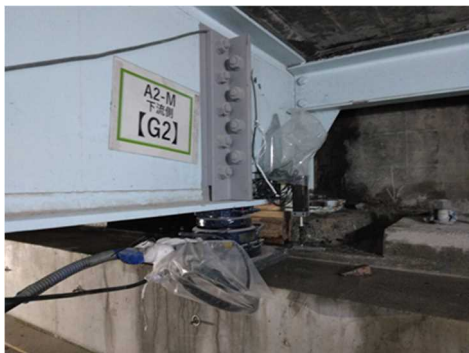
写真-8 支承部のジャッキアップ状況
