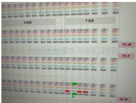
写真-9 ジャッキアップ状況管理画面
