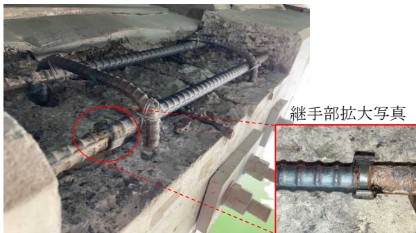
写真-6 新NT工法Ⅱによる切断鉄筋の復旧
