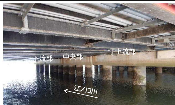
写真-2 桁下現況写真
