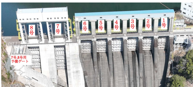
図-1 長安ロダム洪水吐ゲート状況
