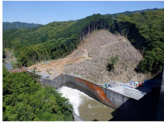
図4 下流右岸の掘削
