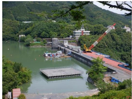
図6 上流仮締切設備
