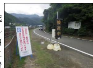
図-5 対向車接近表示装置
