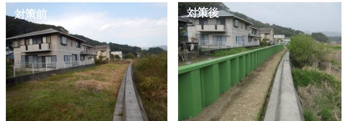
写真-4 局所的に低い家屋の浸水対策(周囲堤対策完成)
