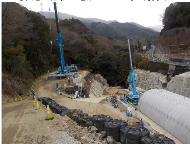
写真-2 施工ヤード全景
