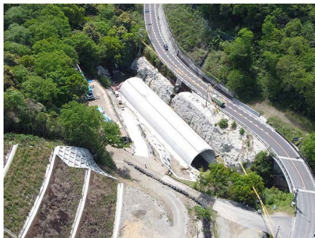
写真-4 組み立て完了状況
