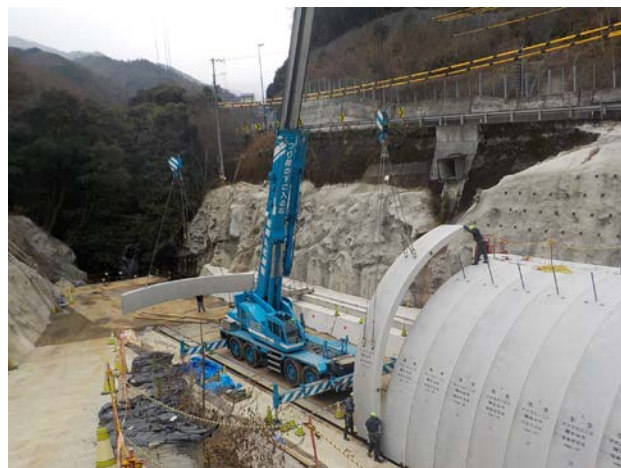
写真-3 組み立て状況
