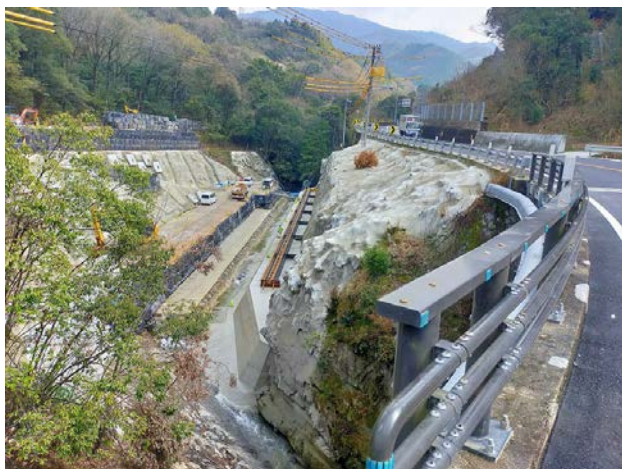
写真-1 施工箇所の全景
