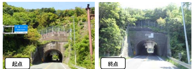
写真-1 引田トンネル
