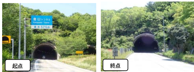
写真-4 金山トンネル（下り）
