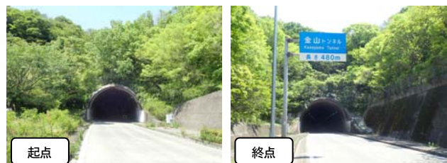
写真-3 金山トンネル（上り）
