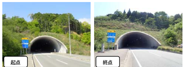
写真-2 前山トンネル
