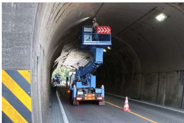
写真-5 高所作業車を用いた点検の状況
