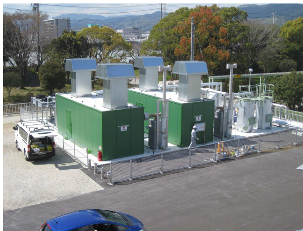
図-3 消化ガス発電施設
