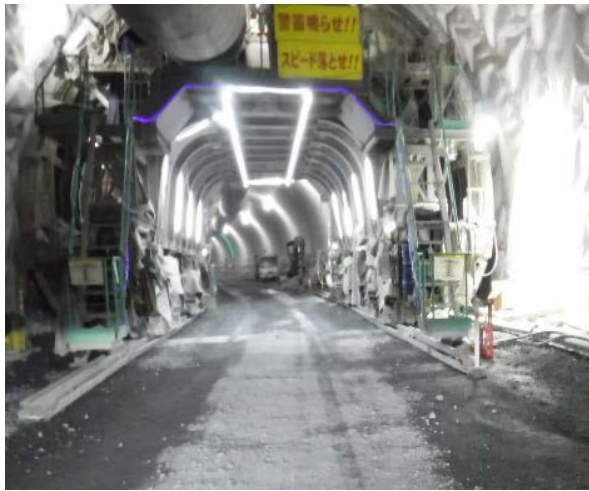
写真-1 見の越トンネル施工状況
