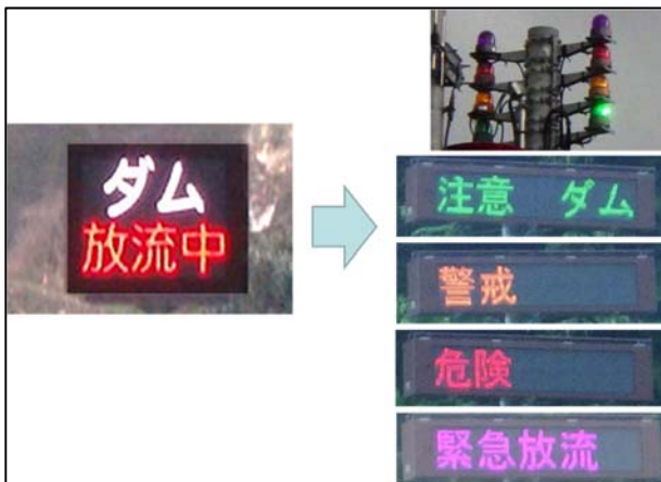
図ー5 電光掲示板等の改良
