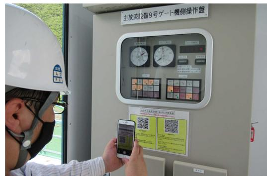
写真-2 機側操作盤での読取状況
