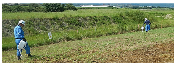
図-9 塩水の施工状況
