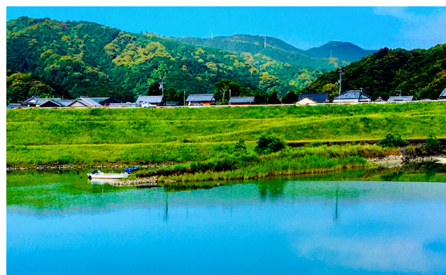
図-2 堤防除草試験施工 イメージ
