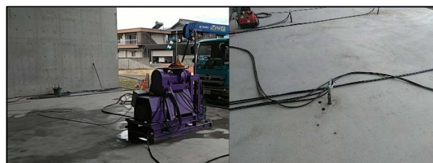
写真-2 JOG工法による施工状況（削孔・注入）
