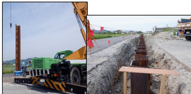
写真-3 鋼矢板施工状況
