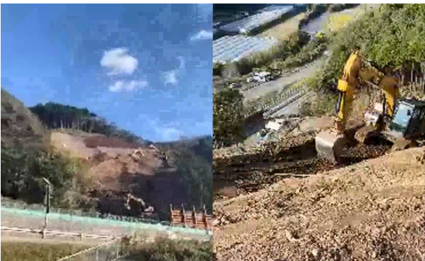
写真-1 窪川佐賀道路拳ノ川大規模切り土現場 左：下から撮影・右：上から撮影
