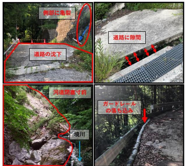
図5. 地すべりによる被災箇所(有瀬地区)
