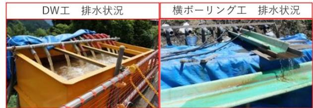
図6. 応急対策工による排水状況（当時）
