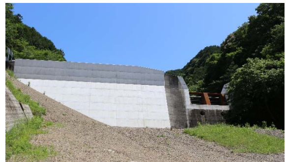
写真-6 渋谷第2号堰堤（改良後）
