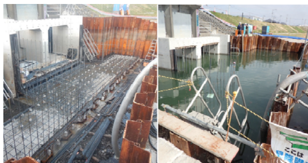
写真-5 ポンプによる水替え
