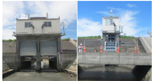
写真-2 天神前樋門（左）、前田樋門（右）
