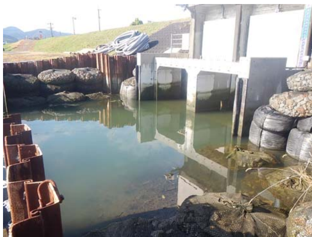
写真-6 袋詰め玉石による床止め
