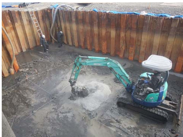
写真-4 表層安定処理工による地盤改良
