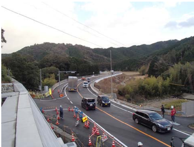
写真-7 増田視距改良の開通後の様子(地上) (R3. 12. 8)
