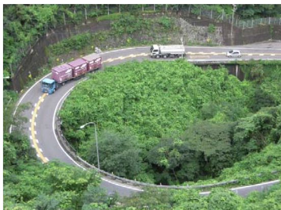
図3 車線を逸脱して走行する大型車の様子
