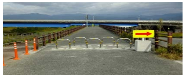
写真-3 物部川左岸0k/2付近 衝突対策事例
