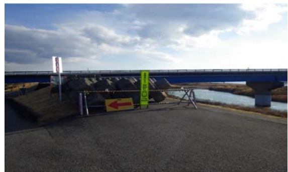
写真-2 物部川左岸0k/4付近 衝突対策事例
