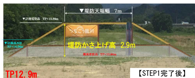
図-11 嵩上げ後の堤防状況
