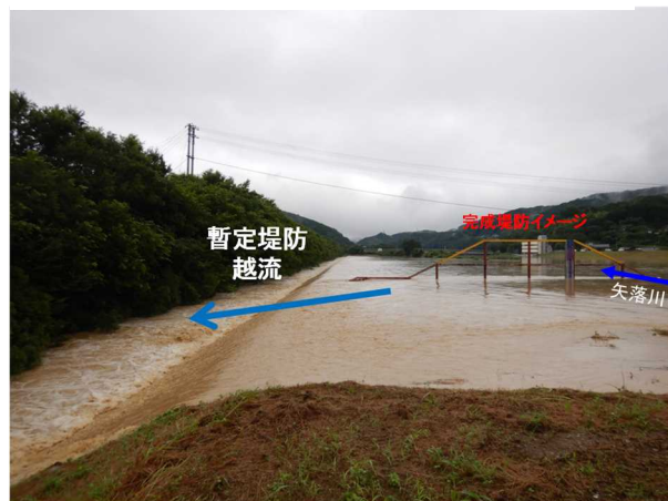
図-2 東大洲地区暫定堤防越流状況（2018年7月）
