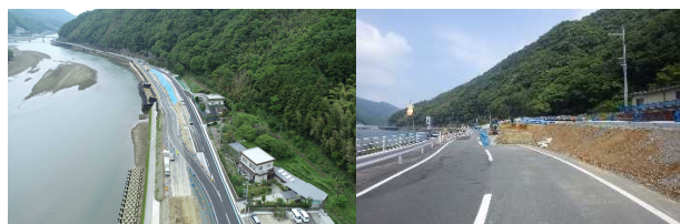
図-9 工事期間中の迂回路の例
