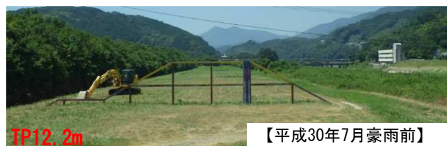
図-10 嵩上げ前の堤防状況
