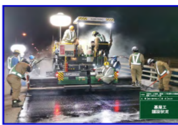
グースアスファルト施工
