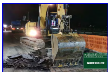
既設舗装版撤去
