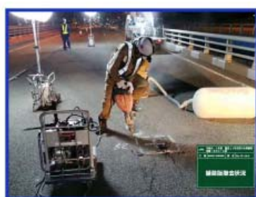
既設舗装版撤去
