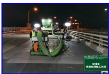
鋼床版の研掃
