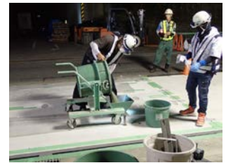
写真-22 グラウト材充填
