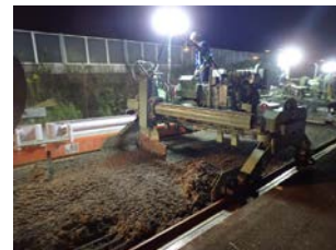
写真-8 敷き均し
