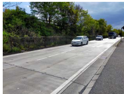
写真-24 プレキャストコンクリート舗装版（高強度PRC版）部
