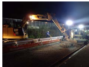
写真-7 コンクリート打設
