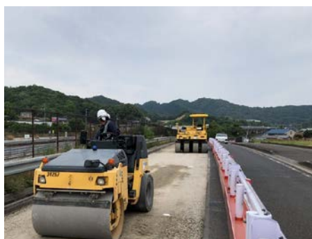
写真-6 路盤工の施工状況
