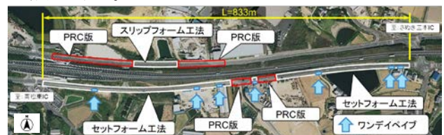
図-7 各工法の施工箇所
