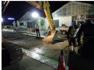
写真-15 コンクリート打設
