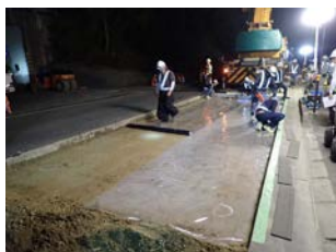
写真-19 ビニール敷設
