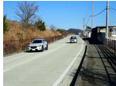
写真-23 連続鉄筋コンクリート舗装部
