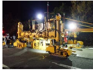
写真-12 敷き均し～締め固め
