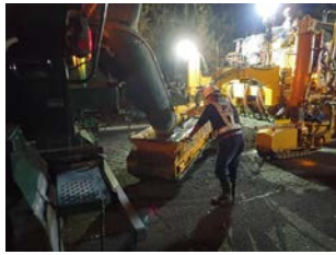
写真-11 コンクリート打設
