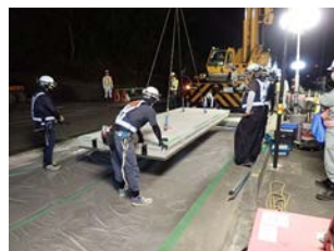
写真-20 PRC版据え付け
