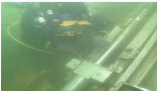
写真-7 潜水士による水中での据付状況
