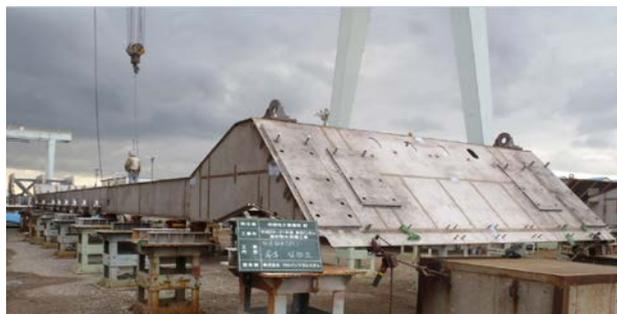
写真-3 低層取水ゲート設備組立状況
