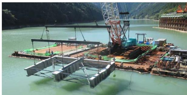
写真-4 200tクレーンによる吊込状況
