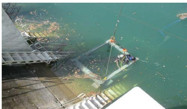
写真-5 専用測量治具(1段分)調整状況
