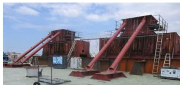
写真3 中央径間搭載用の架台
