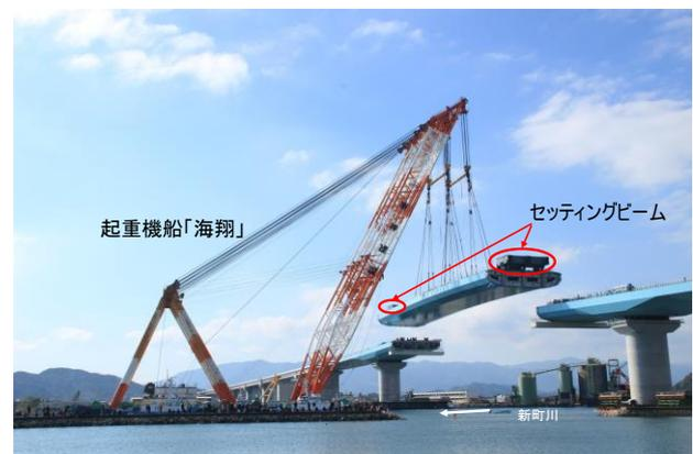
写真4 起重機船「海翔」を用いた中央大ブロック架設の様子
