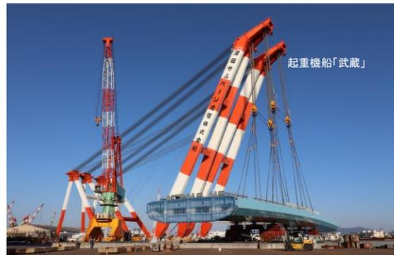
写真2 起重機船「武蔵」を用いた中央大ブロックの浜出しの様子
