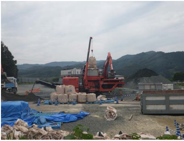
写真-2 ベントナイト混合土作成状況
