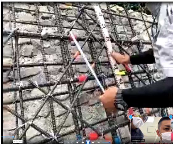
写真-10 配筋検査
