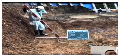
写真-9 床掘確認
