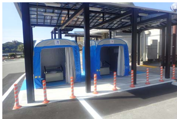
図-8 汲み取り式マンホールトイレ設営状況
