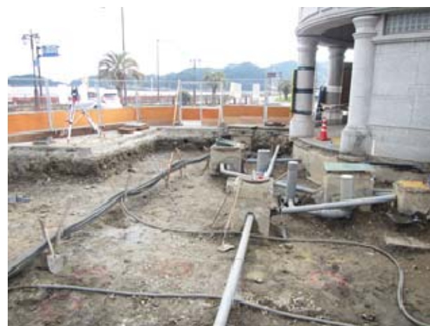
図-9 管路の試掘状況
