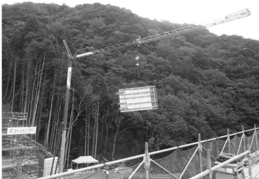
写真5 クレーンの作業状況（型枠）
