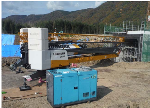
写真-6 定置式水平ジブクレーン（組立前）
