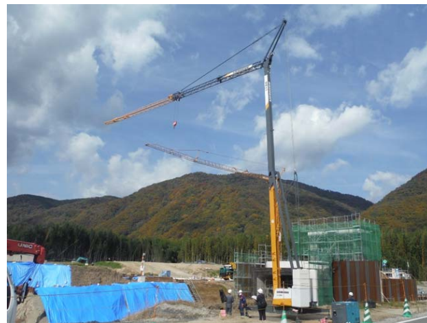
写真-1 定置式水平ジブクレーン（全景）
