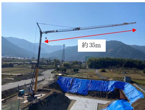
写真-7 水平ジブクレーンの作業半径
